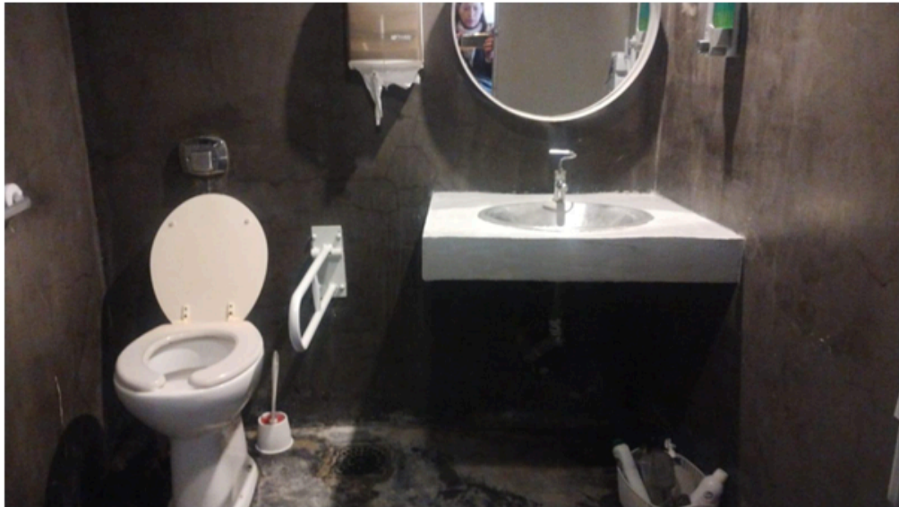
Vista general del sanitario
