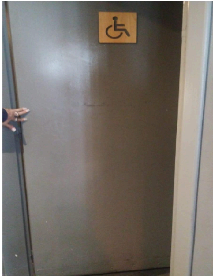
Puerta de ingreso al sanitario accesible. Ancho 0.81m
